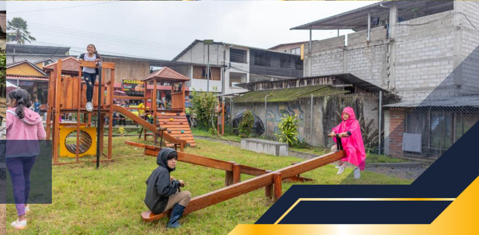
Reconstrucción del Parque Infantil Ubicado en el barrio El Triunfo,
